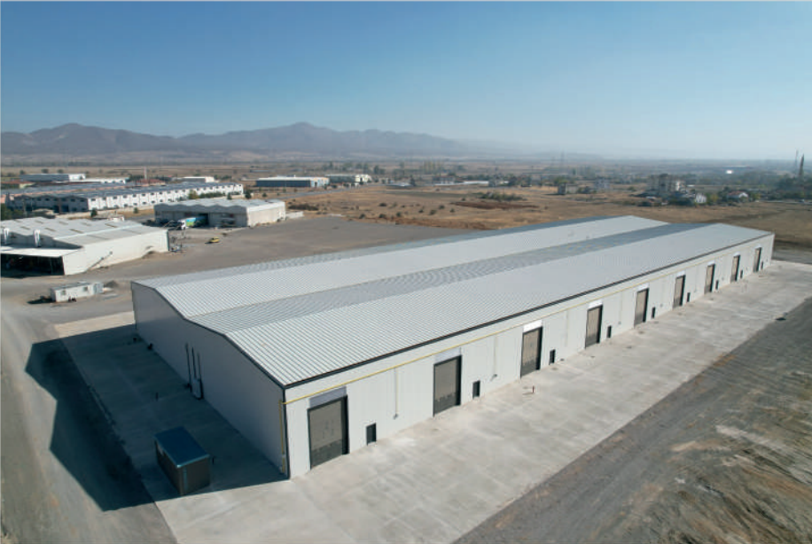
Seydişehir Soğuk Hava ve Kurutma Tesisi
